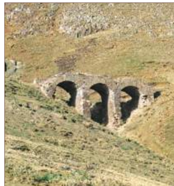
Steinbrücke in der Nähe der Siedlung Sjabatketschmyaz in Gadabay, 19. Jahrhundert
